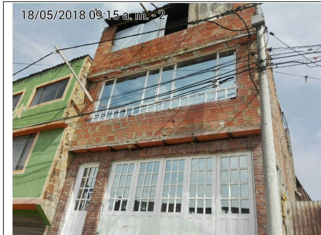
FOTO N°. 1 FACHADA DEL PREDIO.
