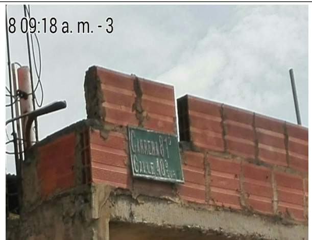
FOTO N°. 2 NOMENCLATURA URBANA .
